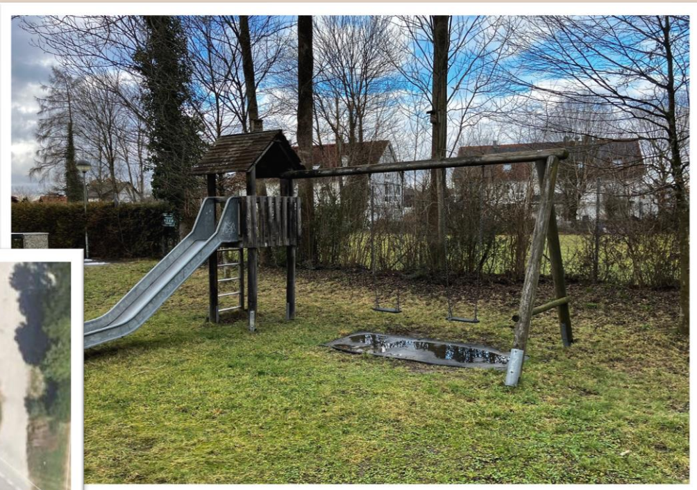
SANIERUNG SPIELPLATZ TANNENWEG
