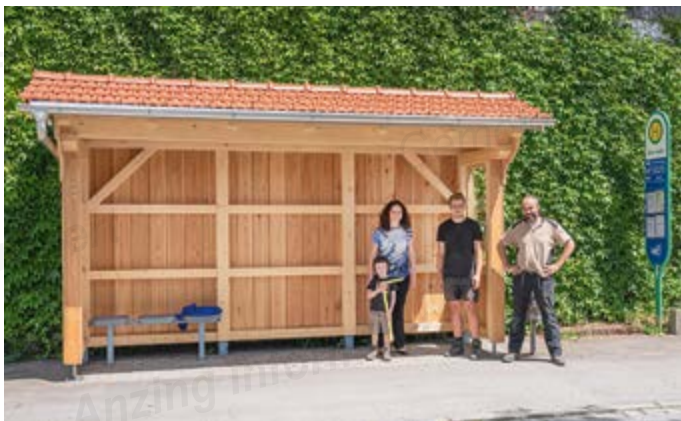
(von links): In der Högerstraße bauten Ferdinand Böhm (im Bild vor Bgm. Kathrin Alte), Maximilian Finauer und Andreas Böhm das neue Bushäusl.
